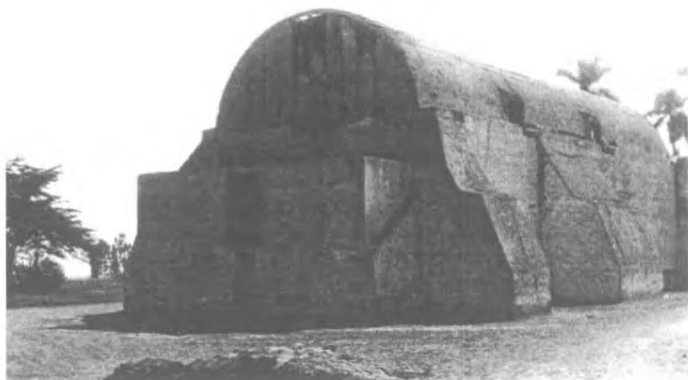
IGLESIA DE SAN PEDRO DE CARABAYLLO: VOLUMETRIA Exteriormente las dimensiones de los muros y contrafuertes dan una volumetría de gran solidez destacando la clara concepción estructural de su función.
